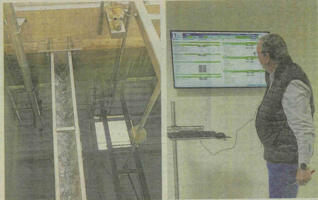
À gauche : l'eau pompée dans le forage est envoyée au 3<sup>e</sup> étage de l'usine où son cycle de traitement commence par la filtration à base de charbon actif. À droite : L'écran de contrôle permet de vérifier tous les paramètres de l'eau en cours de traitement dans l'usine de Bourdainville
